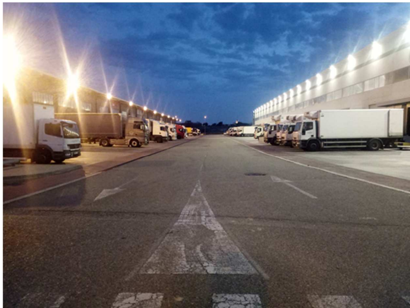
Exemple de reposició d'enllumenat viari amb tecnologia LED
