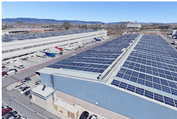
Edifici multipropietari Nau 8 Cim El Camp. Reus. d'energia. Font: Cimalsa
